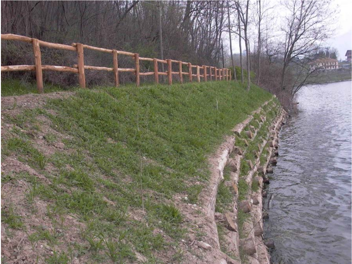
palificata spondale la primavera successiva
