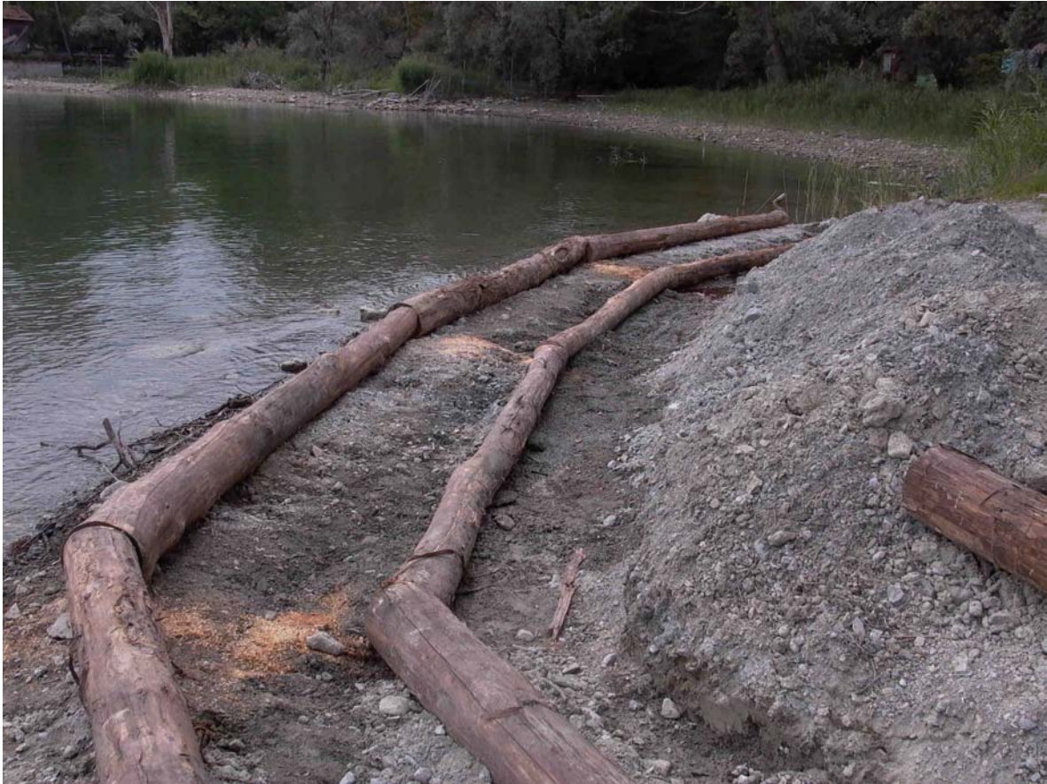
zona umida: palificata spondale in costruzione
