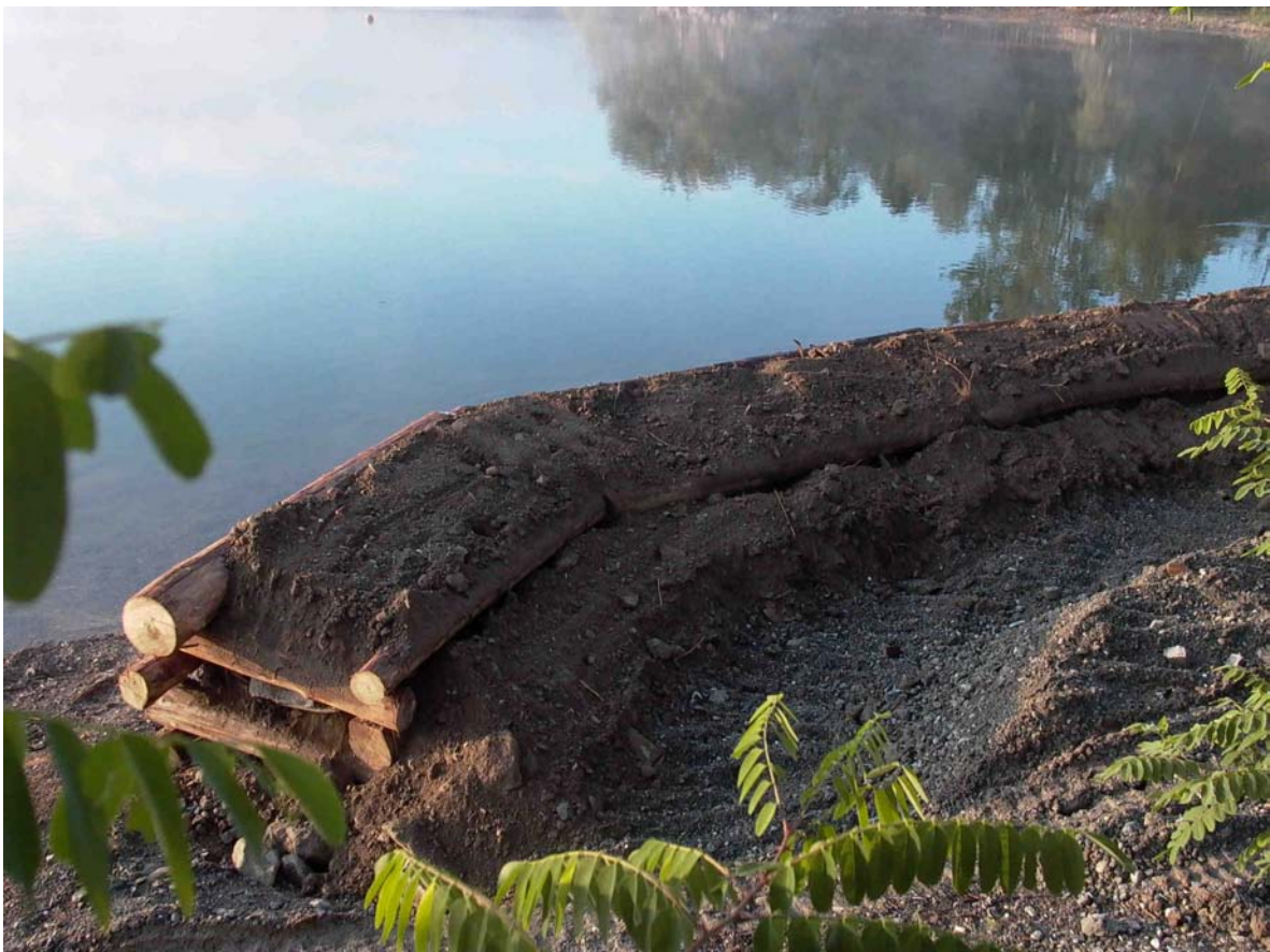
zona umida: palificata spondale in costruzione
