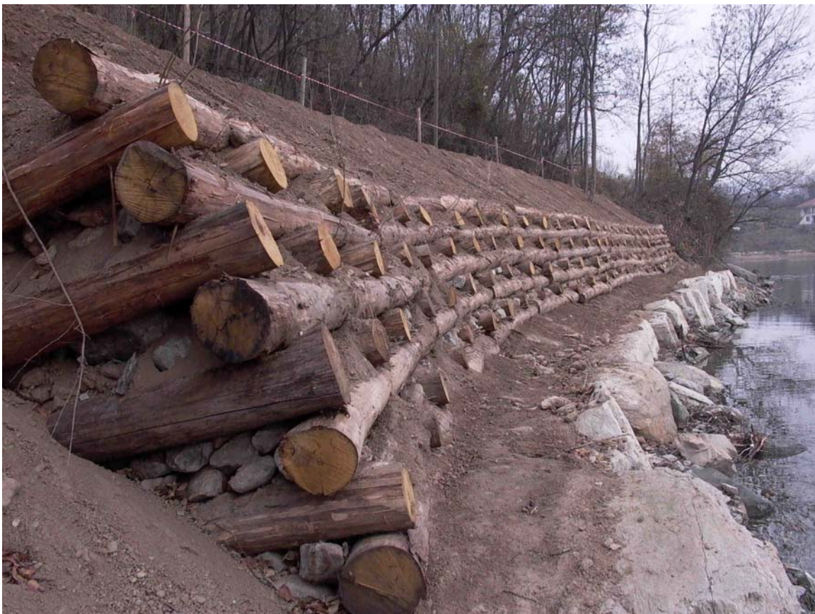
palificata spondale in costruzione
