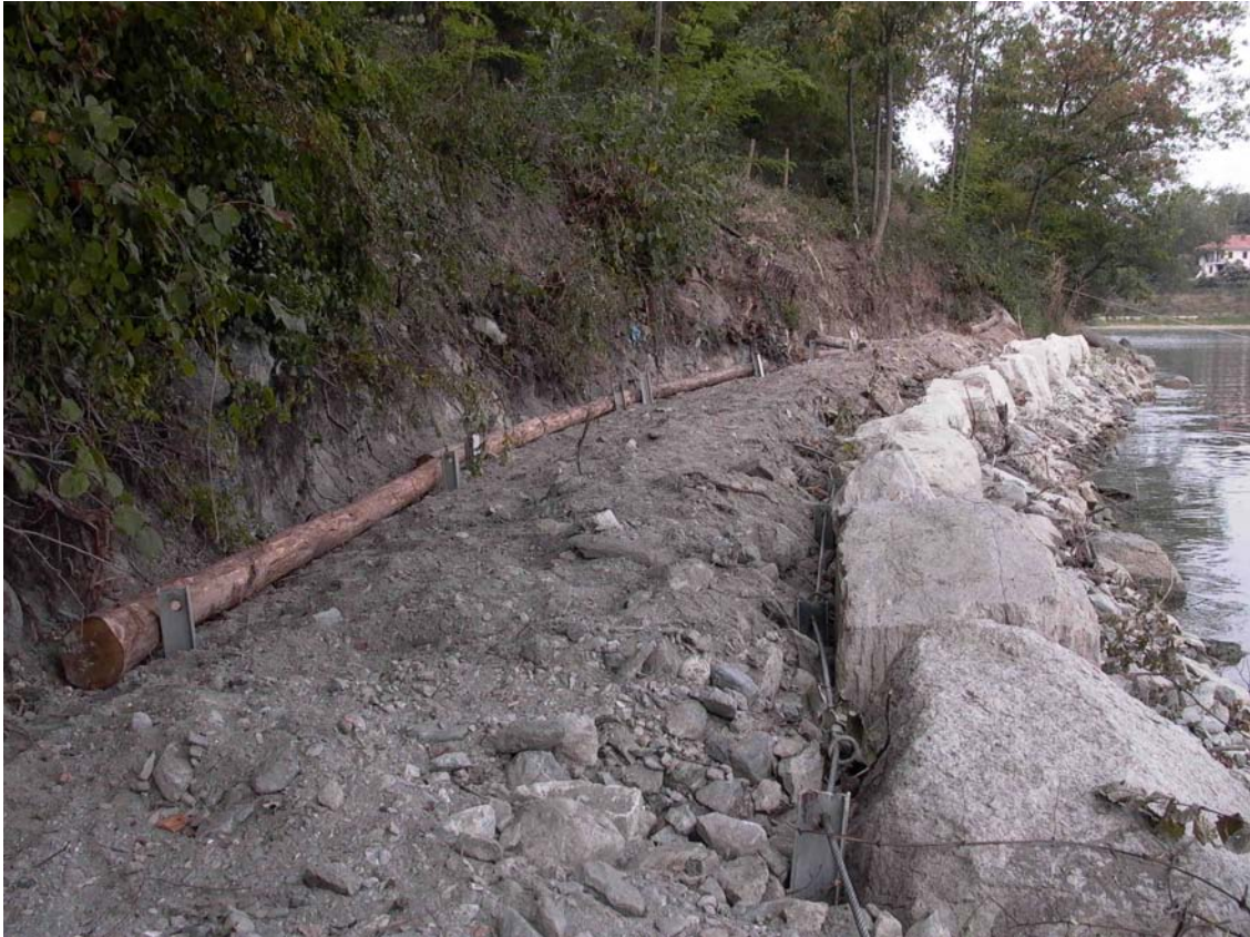
scogliera con massi vincolati in costruzione
