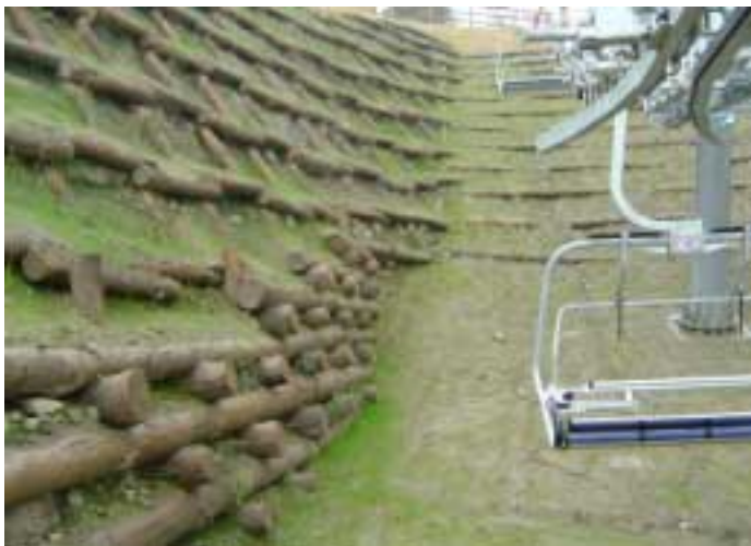
Sauze d'Oulx. Palificate e grate vive, con successivi interventi di idrosemina, a stabilizzazione e ottimale inserimento ambientale delle ripide pareti della "buca" scavata per realizzare la stazione di partenza della nuova seggiovia
