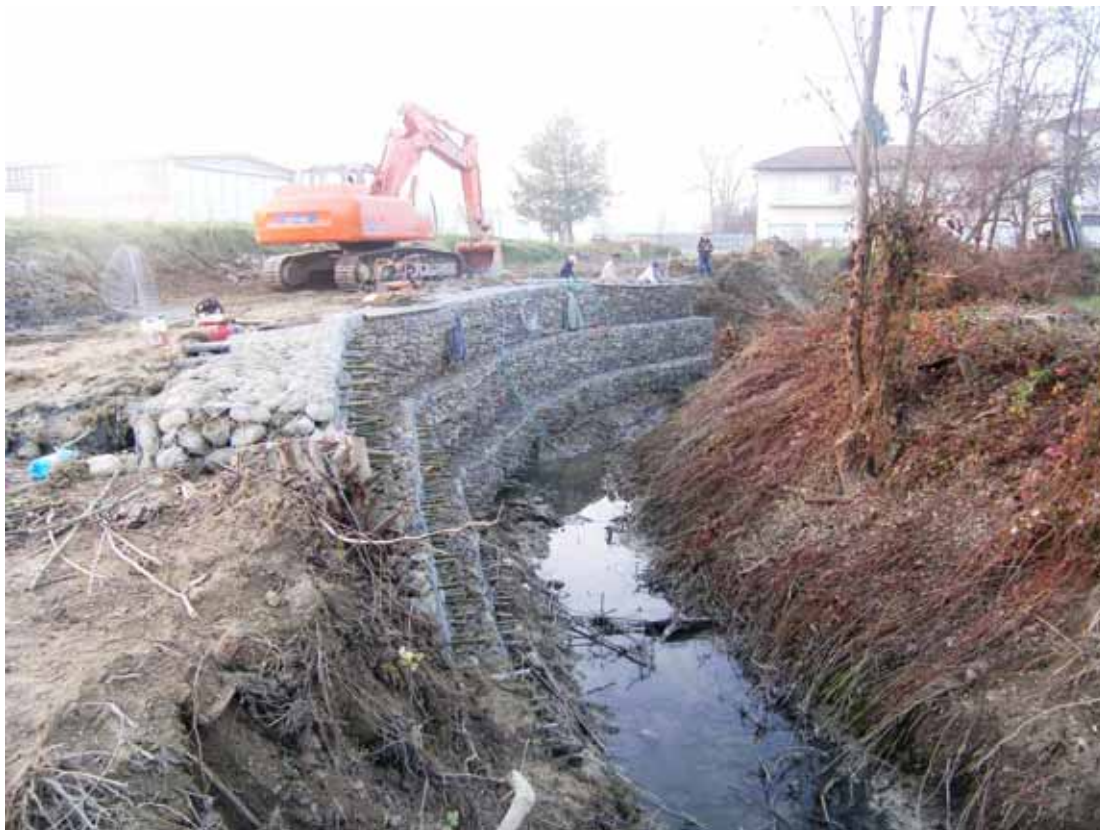
Consolidamento spondale con gabbionate rinverdite con talee di salice
