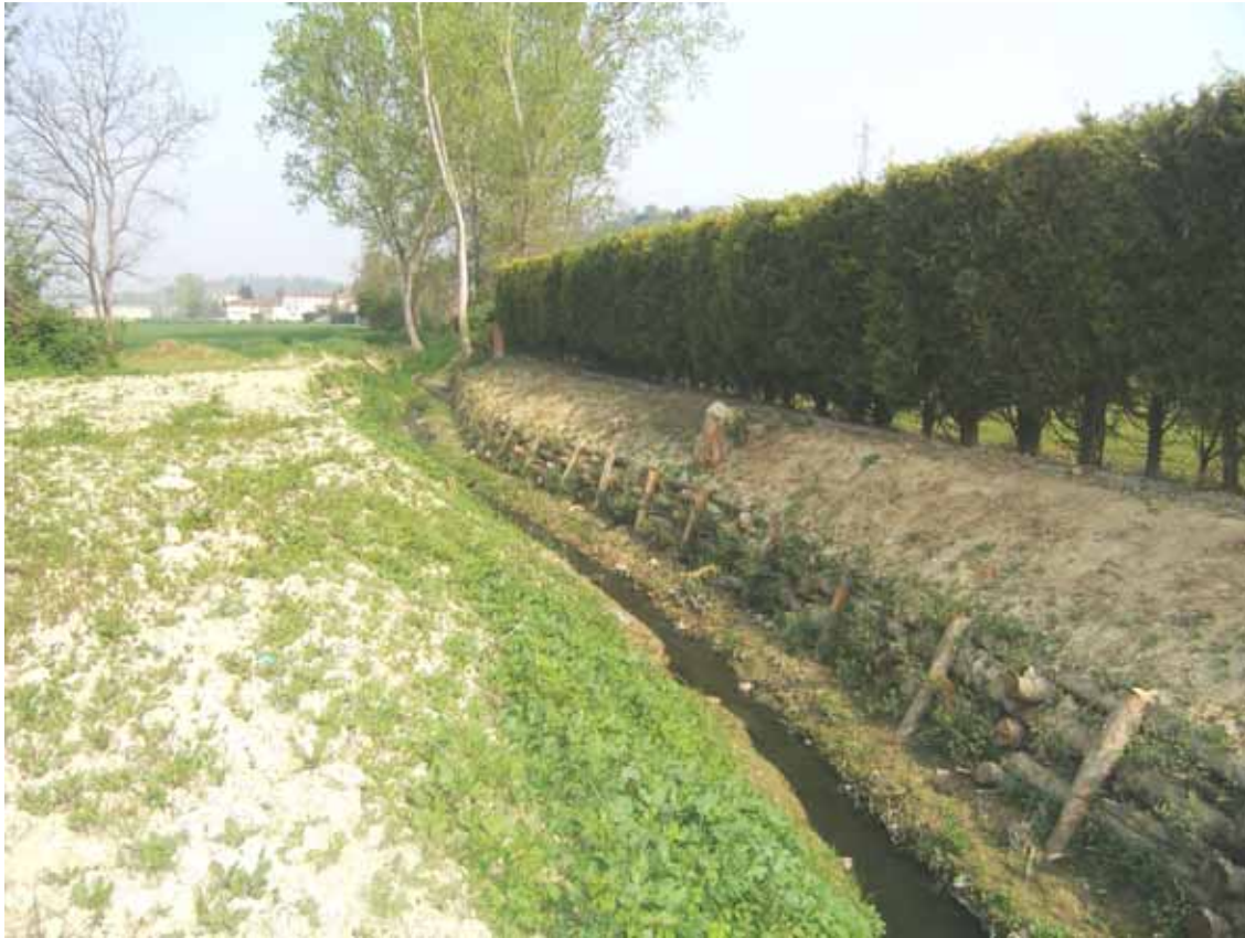
Palificata a una parete
