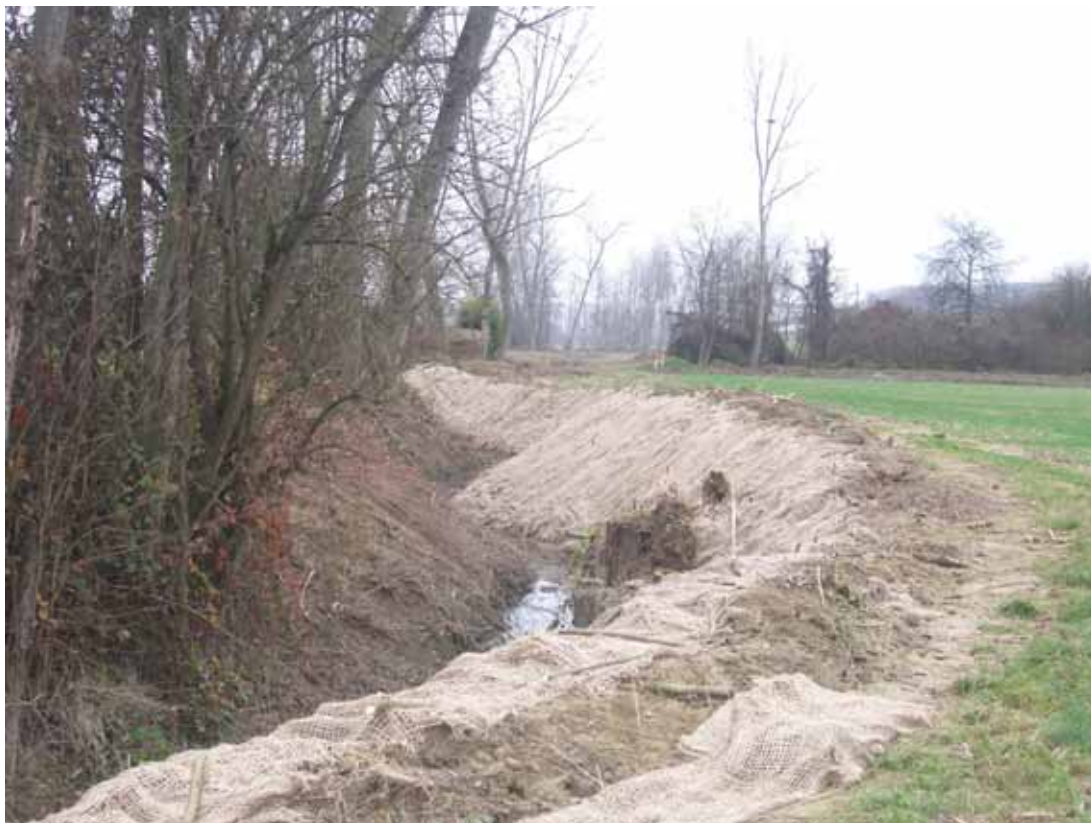
Rivestimento della sponda rimodellata con geostuoia di juta
