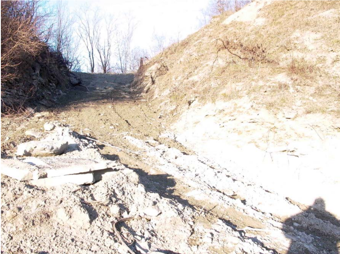
tratto di percorrenza prima delle opere
