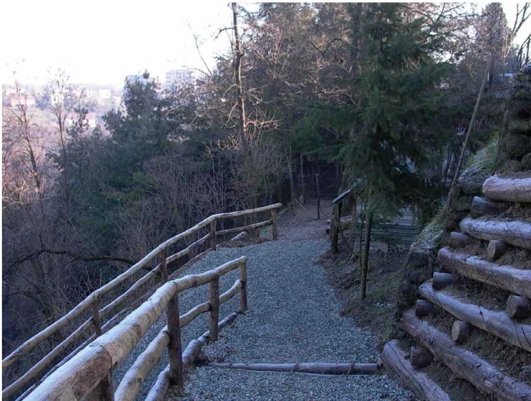
versante dopo le opere (4 palificate di sostegno sovrapposte sotto e sopra strada)
