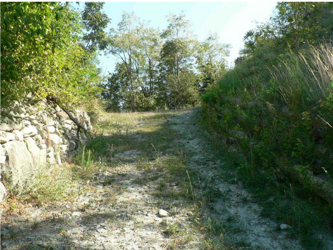
tratto di percorrenza dopo le opere con a dx muretto a secco
