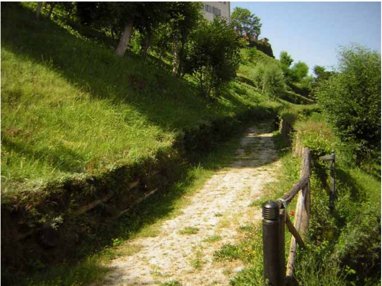
Foto 3. Dogliani veduta del sentiero con palificate rinverdite.
