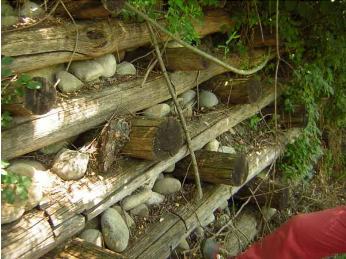
Foto 5. Alba- palificata drenante in corrispondenza di impluvio.
