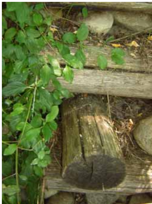
Foto2. Alba- particolare di palificata in castagno.
