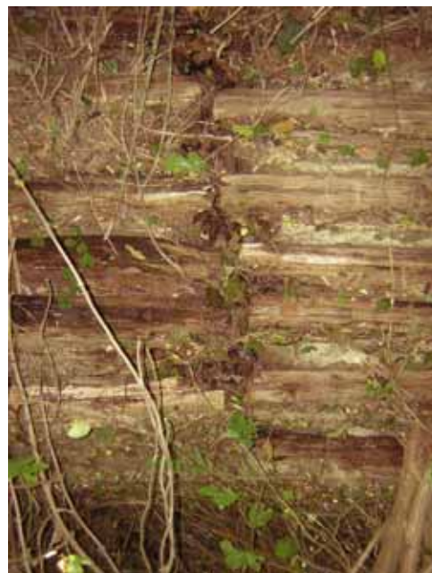
Foto 7. Diano- cedimenti del legno in corrispondenza delle chiodature. A destra, struttura collassata su se stessa.
