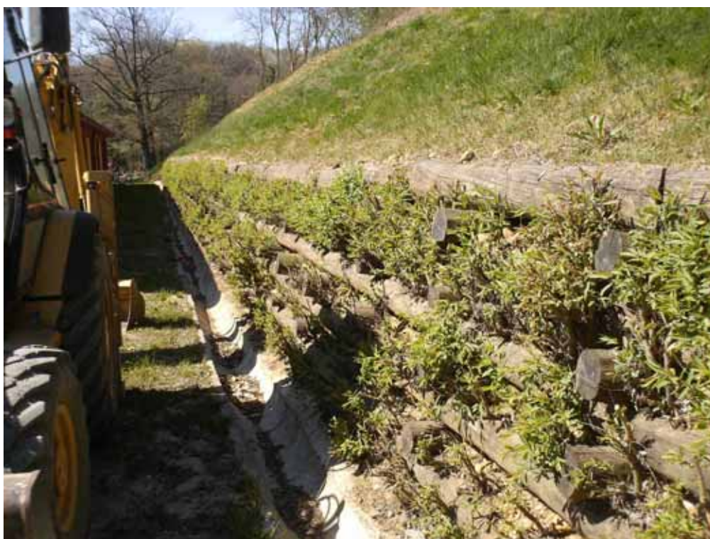
Palificata doppia realizzata con legno di quercia rossa risultante da abbattimenti nel Parco. Salici potati e mantenuti "a raso", a ridosso di edificio di servizio del Parco
