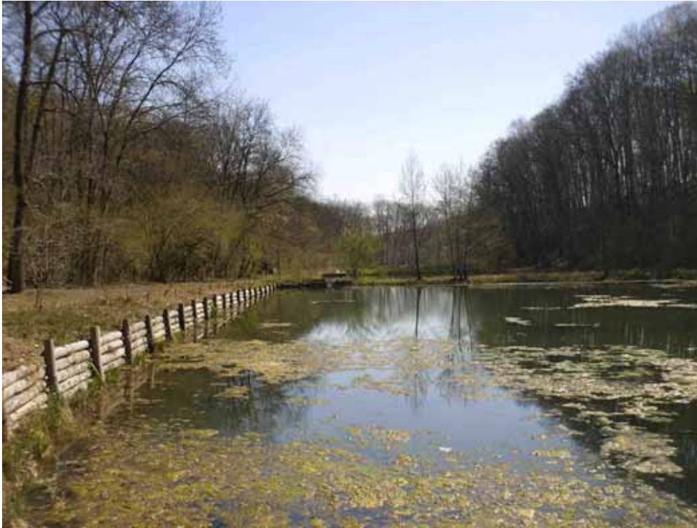
Opere di contenimento di sponda di lago artificiale: palizzata con tirante posteriore
