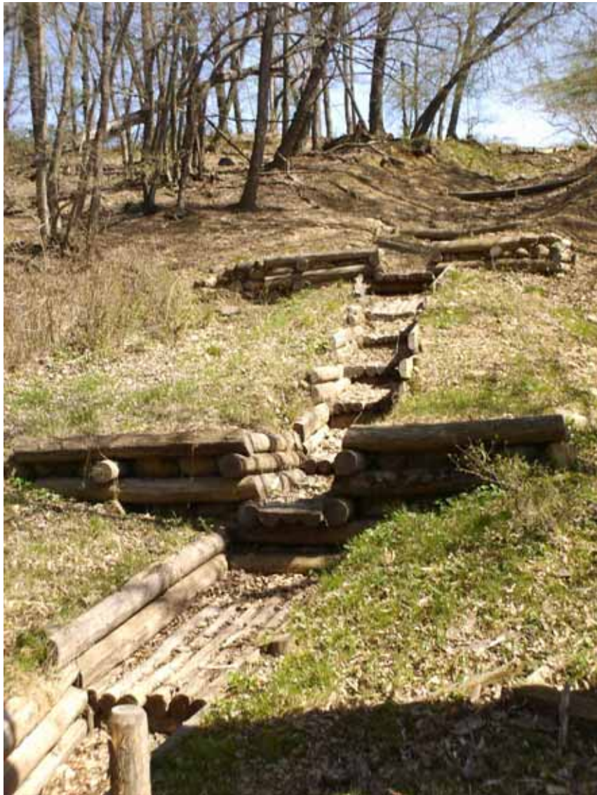
Canale di raccolta acque di scolo da un'ampia area prativa con serie di mini briglie, opera realizzata dal Parco con mezzi e operai propri nel 2005, legno di robinia scortecciata
