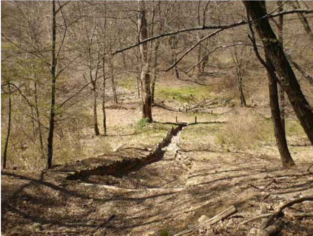
Canale di raccolta acque visto dall'alto
